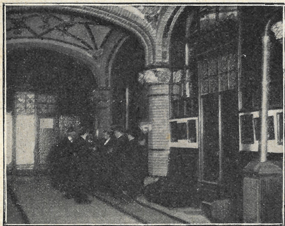
Vestíbulo del edificio por la entrada del pasaje
