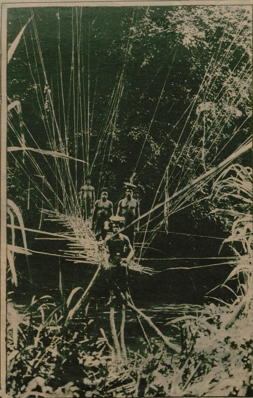
EL UNICO PUENTE COLGANTE. En Nueva Guinea no existe más puente colgante que éste. Lo han construido los indígenas con ramas de árbol y lianas de la selva, sin más ingeniero que su instinto. No obstante, resiste perfectamente el peso de los transeúntes. (Fot. Vidal)
