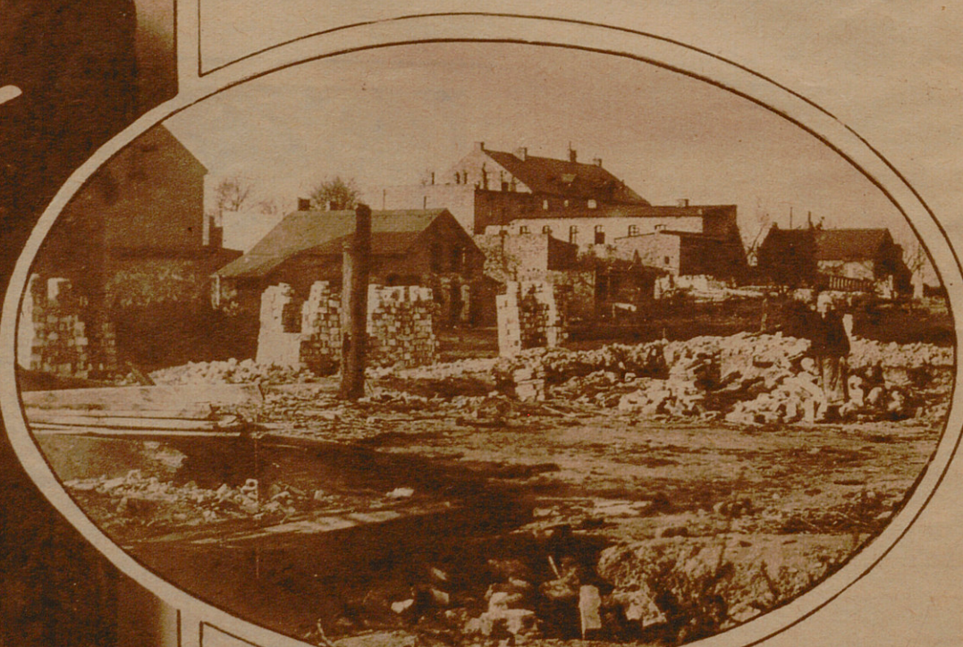
UN PUEBLO QUE SE HUNDE. — Es el pueblo de Rauno (Alemania), que se hunde literalmente, no en sentido figurado. A pesar de todos los trabajos que se realizan para contener el descenso del terreno, éste sigue deprimiéndose con el consiguiente estrago para edificios y peligro para los habitantes. (Fot. Sherl).
