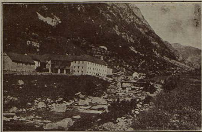
VISTA DEL BALNEARIO
