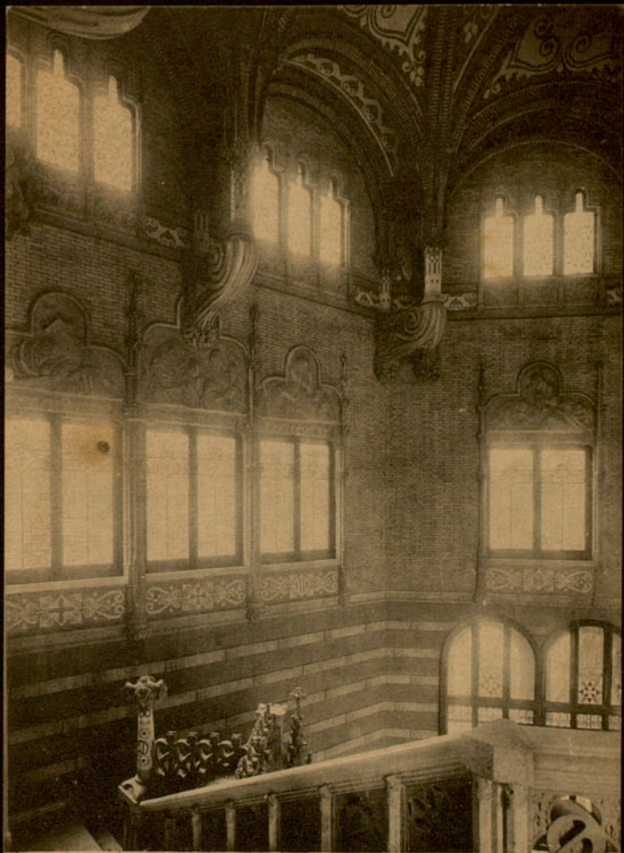
12 - Hospital de San Pablo. Edificio de Administración. Caja de la escalera principal.
