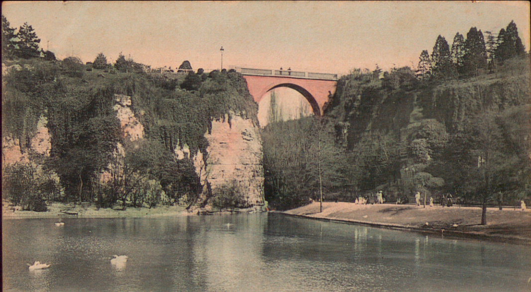
PARIS. - Les Buttes Chaumont - Le Pont de Briques
