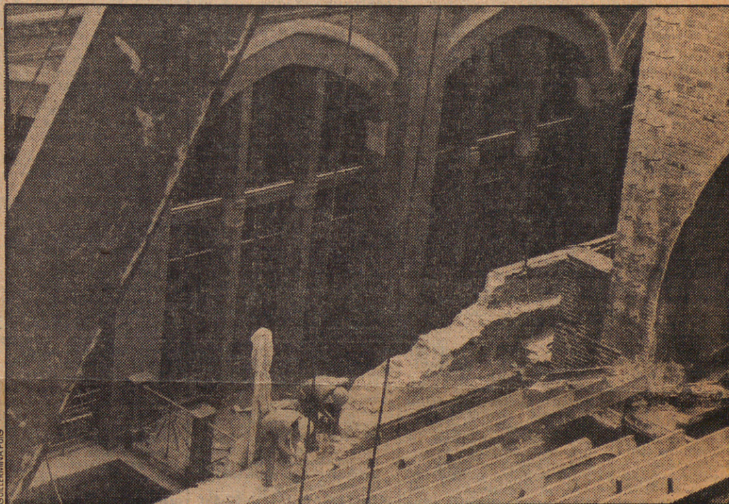
Un momento de las obras de demolición efectuadas ayer en la iglesia de Sant Francesc de Paula
