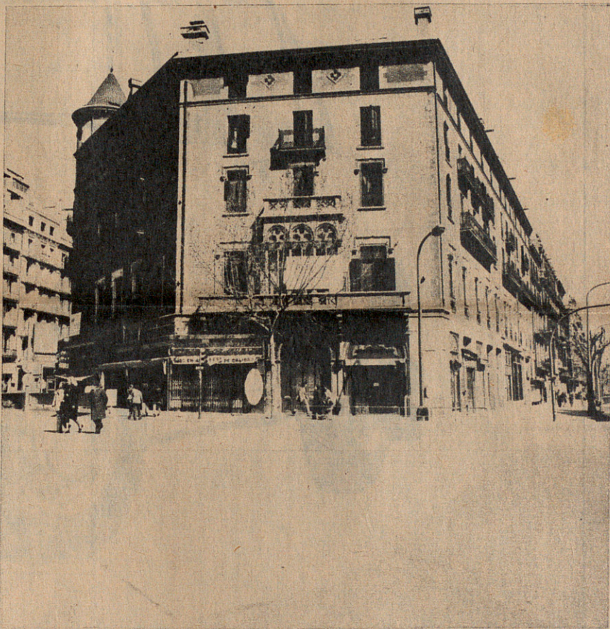
Casa del marqués de Sentmenat, en la plaza de Urquinaona-Ronda, obra de Augusto Font y Carreras, a poco de iniciarse su derribo (Fotos J. & J. Blassi)
