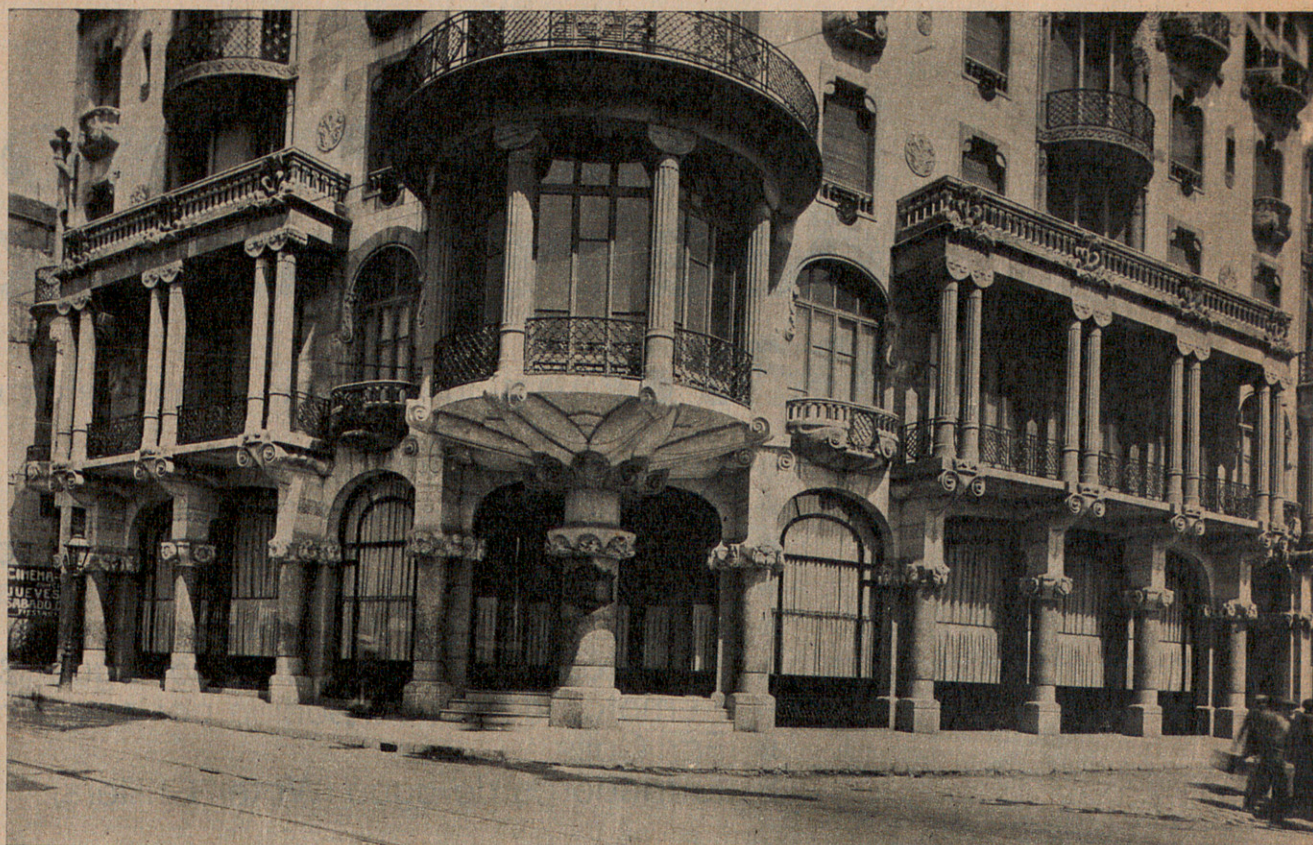
Hay que salvar el conjunto representativo del ya célebre Modernismo barcelonés. Casa Fuster, obra de Domènech y Montaner, a la entrada de la calle Mayor de Gracia
