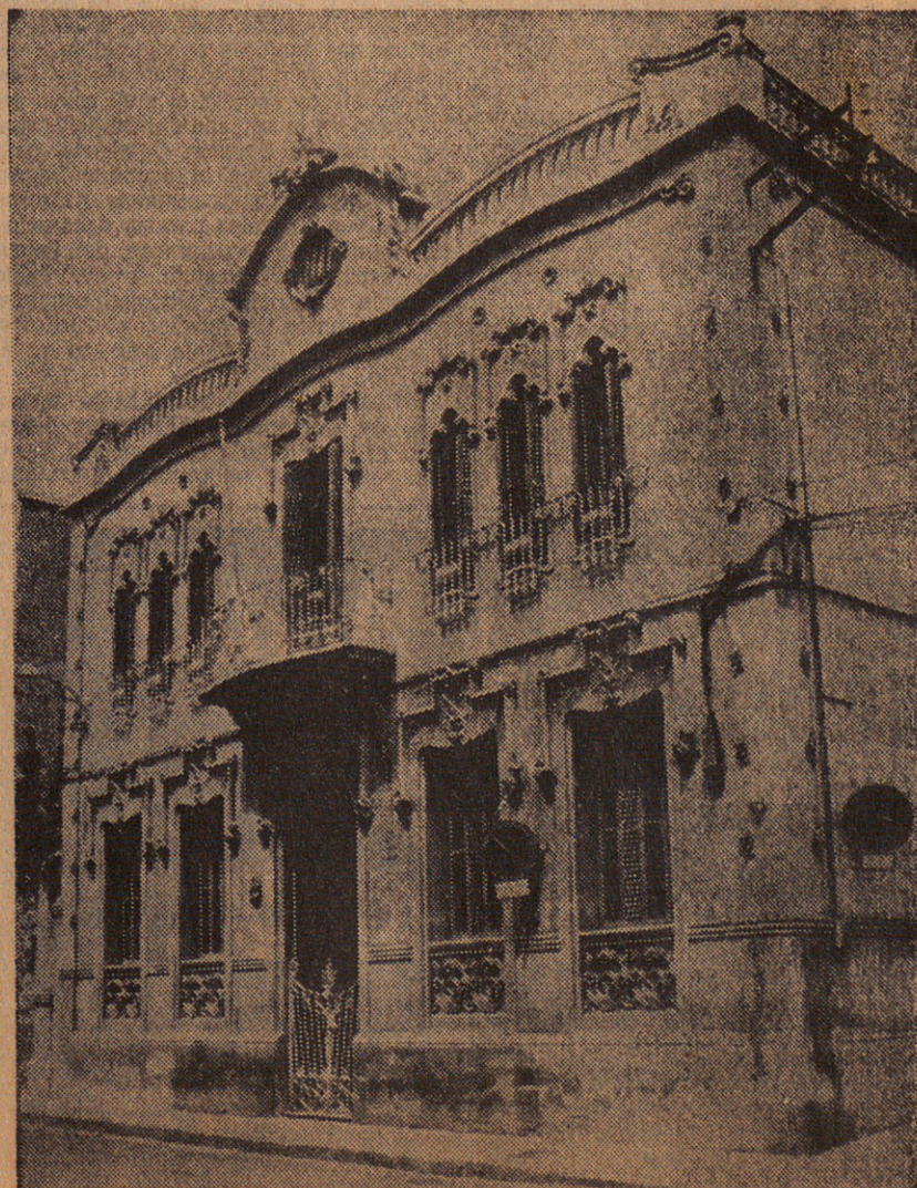
Edificio de la calle San Salvador, 133, construido en 1903. Atribuido a Puig i Cadafalch. Demolido en 1971. — (Foto COACB)
