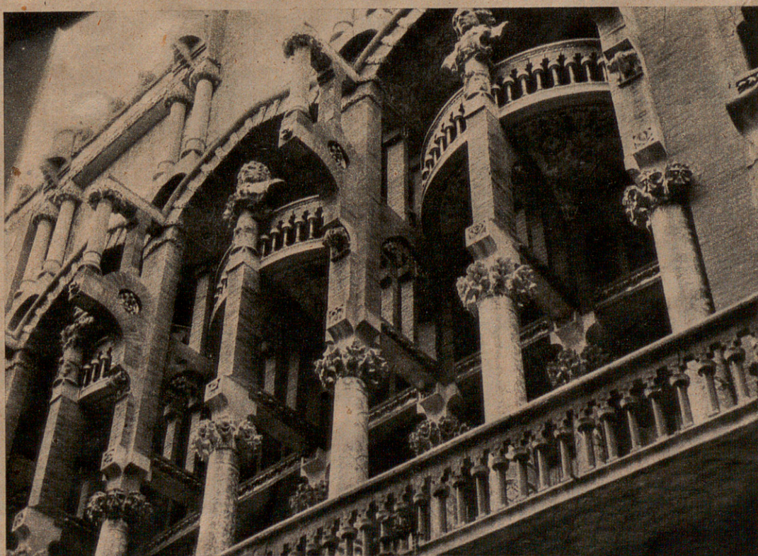
Balcones y elementos estructurales de la fachada principal del edificio, inaugurado en el mes de febrero de 1908
