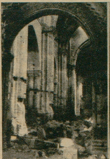
La grandiosa nave central de la vieja Seo ilerdense, la tarea ingente de cuya reconstrucción está encomendada a un puñado de hombres
