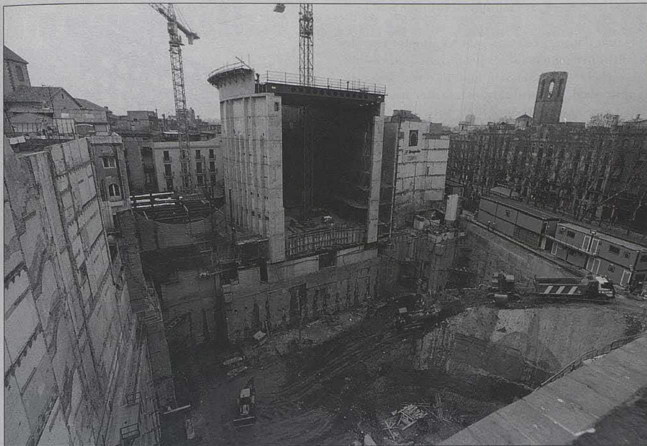
Estat de les obres de reconstrucció el dia 5 de març de 1997
